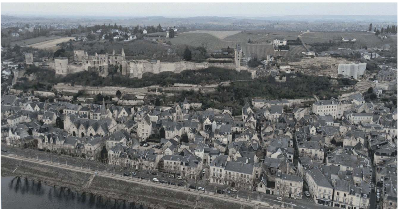
Document 2. Vue générale de Chinon dominé par la forteresse en cours de restauration (cliché Cyb'Air Vision).
