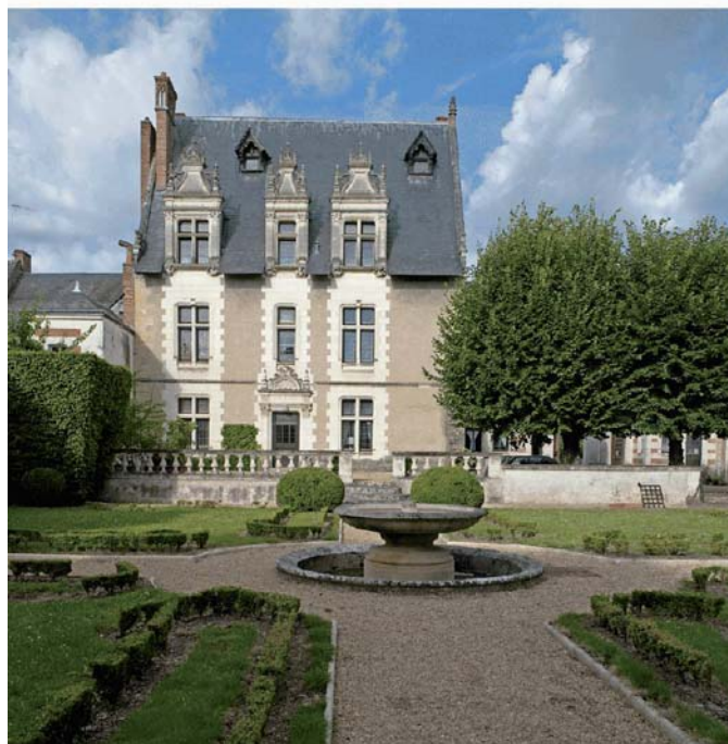
Document 9. Vues de l'hôtel Joyeuse : façade sur rue, façade longitudinale et pignon sur jardin et vue des pavillons d'entrée côté jardin (© Inventaire Centre M. Hermanowicz).
