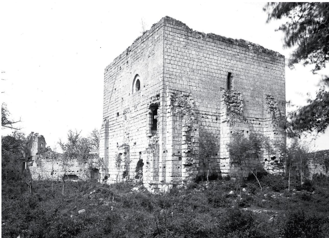
**Document 6.** La tour maîtresse de Semblançay, vue extérieure du sud-est montrant les contreforts rectangulaires, dont la hauteur correspond à celle du rez-de-chaussée, et deux ouvertures à l'étage : à gauche (mur sud), porte d'accès d'origine ; à droite (mur est), petite fenêtre percée au-dessus du contrefort médian (cliché Louis Bousrez, 1896, collection SAT, BFP 0145-0474).
