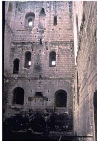
2. Loches, élévation intérieure de la face ouest montrant les trois cheminées superposées encadrées de baies (photo : E. Lorans)
