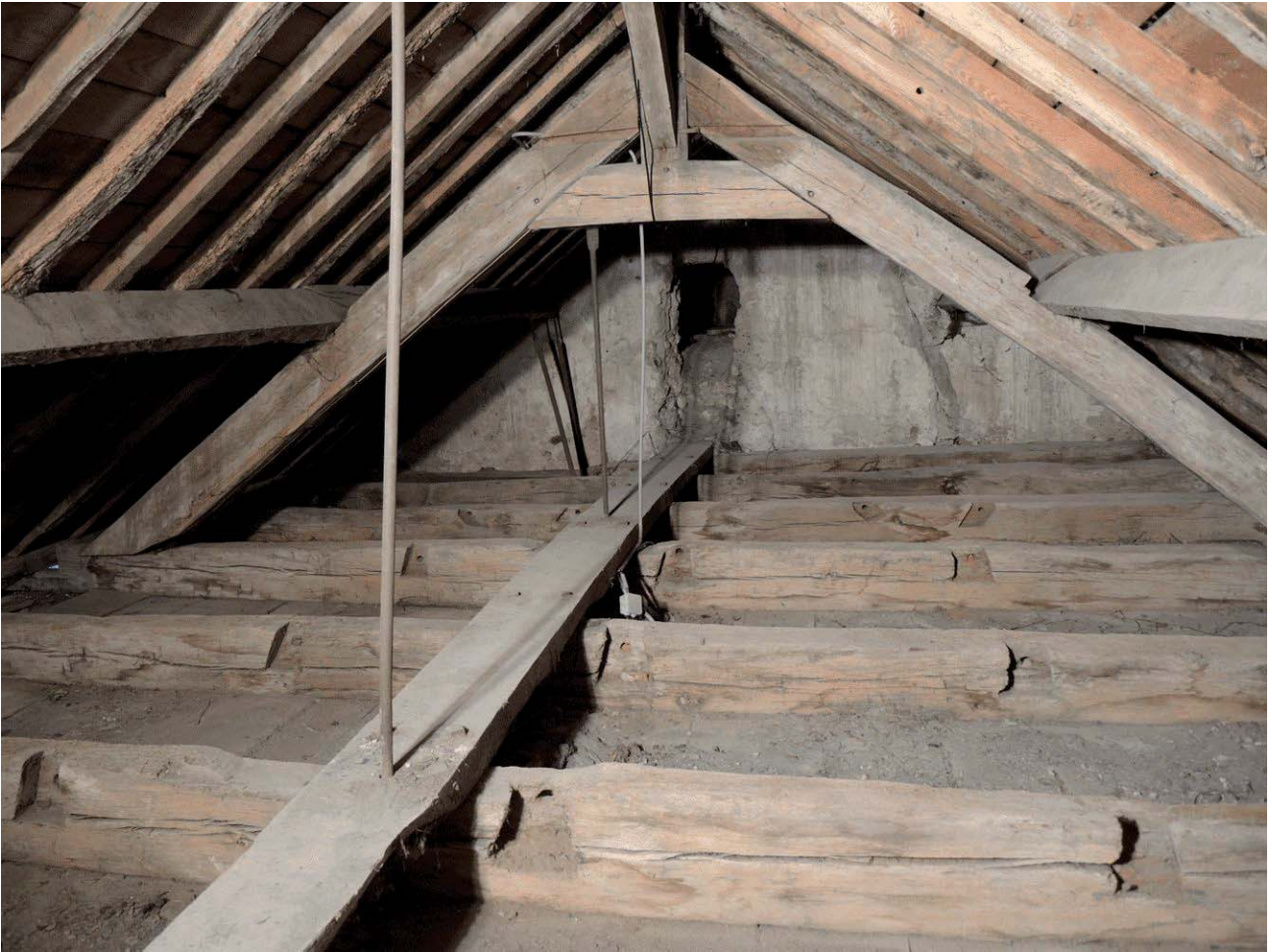
Document 4. Charpente de la nef, vue depuis l'ouest, avec au premier plan les entrails en place (1028d) des fermes d'origine et, au second plan, les entrails rapportés (1127d) lors des travaux du chœur (cliché F. Epaud).
