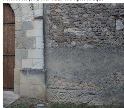
Perrusson (37), mur sud, réemploi antique
